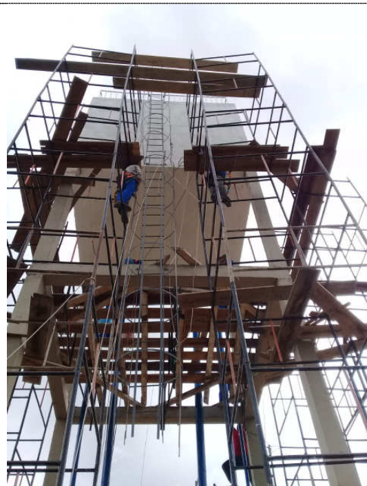
RES. ELEV. – Instalação de parapeito e escada
