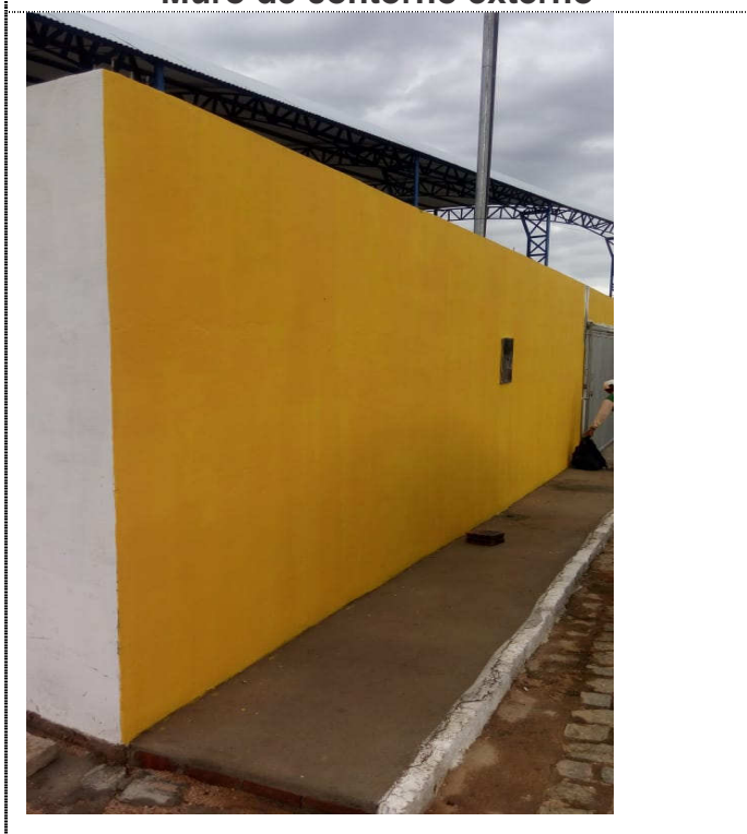
Muro de contorno externo
