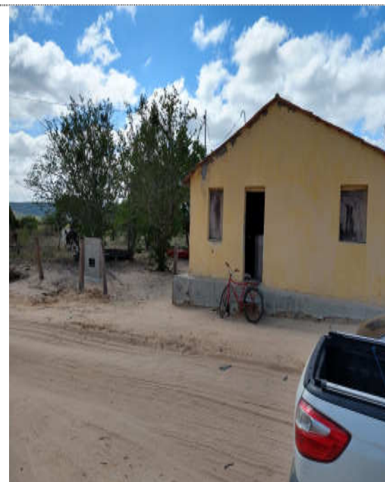
LIGAÇÕES PREDIAIS- Mureta cx. hidrômetros
