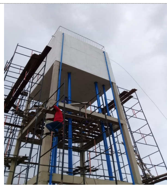
Pinturas e impermeabilização
