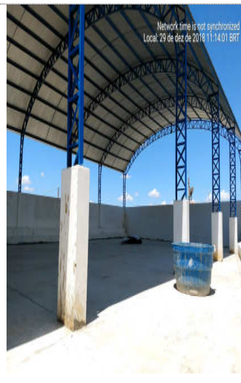
Interior da quadra coberta
