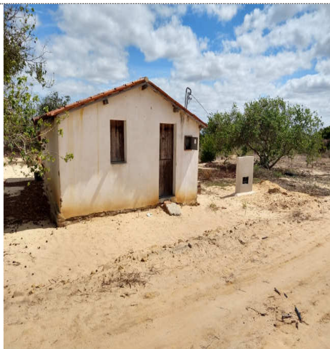
LIGAÇÕES PREDIAIS- Mureta cx. hidrômetros
