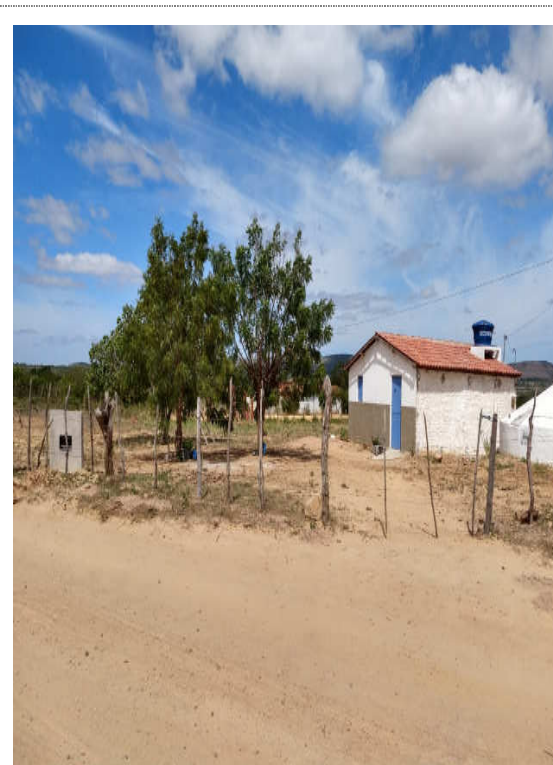
LIGAÇÕES PREDIAIS- Mureta cx. hidrômetros
