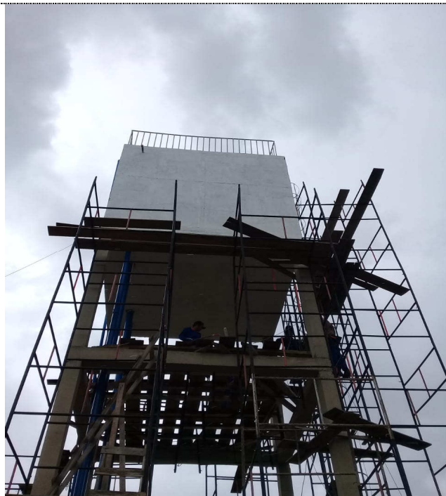
RES. ELEV. – Instalação de parapeito
