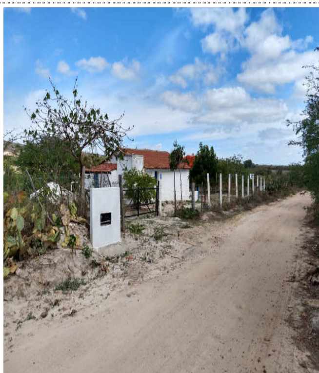
LIGAÇÕES PREDIAIS- Mureta cx. hidrômetros
