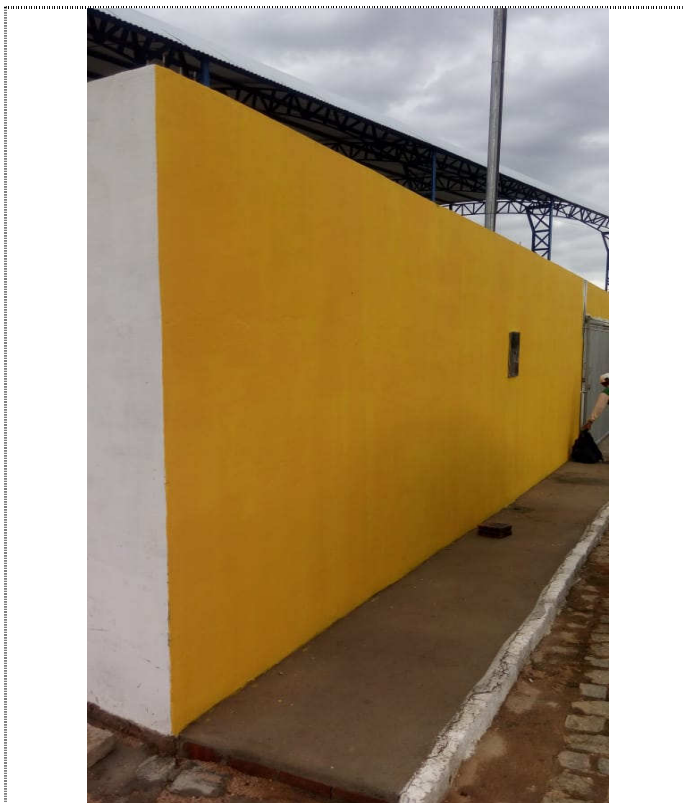
Muro de contorno externo
