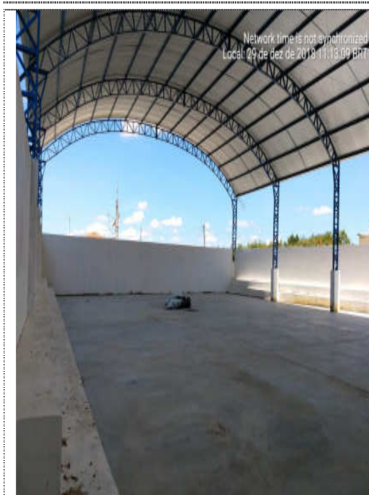
Piso em concreto polido
