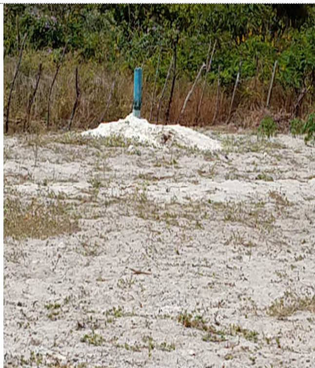
CAPTACÃO- poços perfurados
