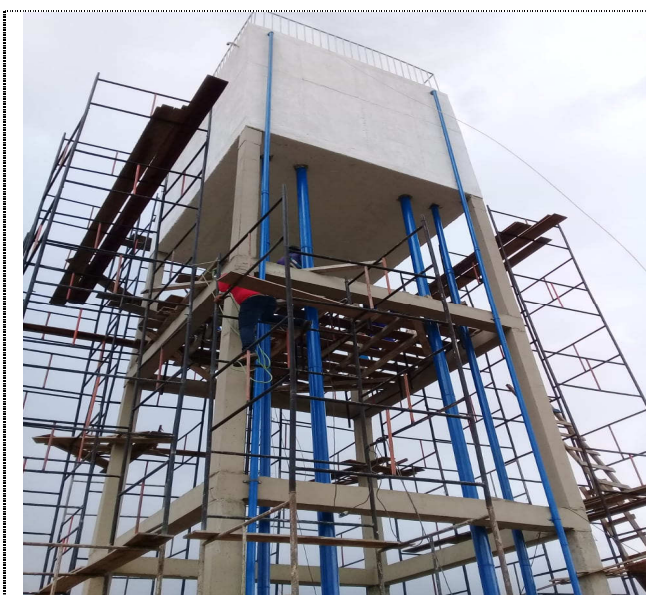
RES. ELEV. – Instalação de barriletes
